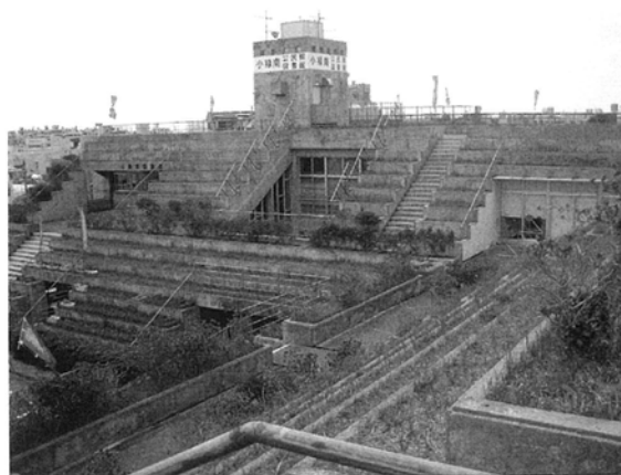
写真2 那覇市小禄南公民館・図書館
