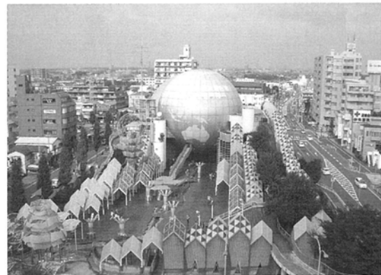
写真3 神奈川県藤沢市湘南台市民センター・公民館
